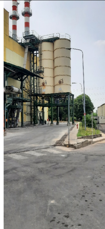
Viabilità in zona di lavoro presa da nord
